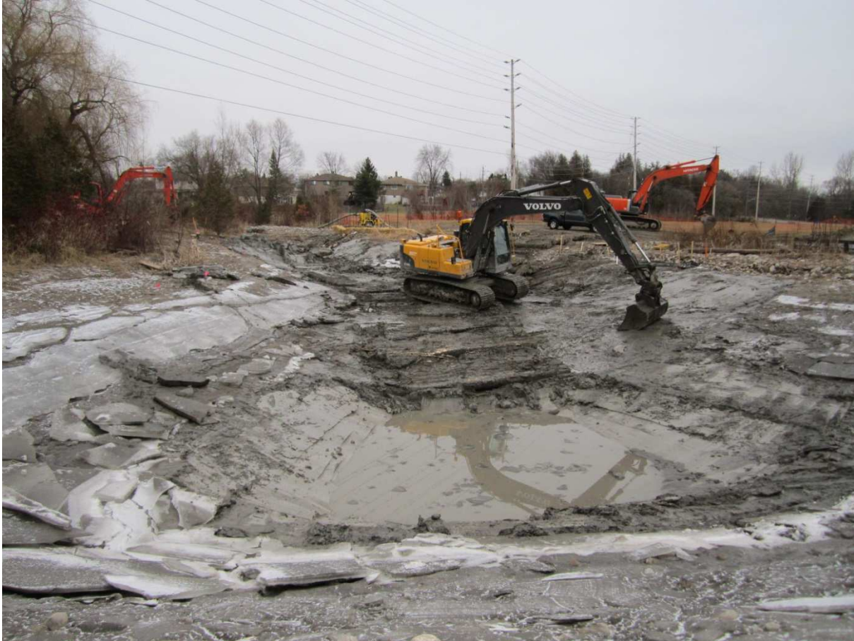
Assèchement et Excavation de Forebay sur le site George Richardson
