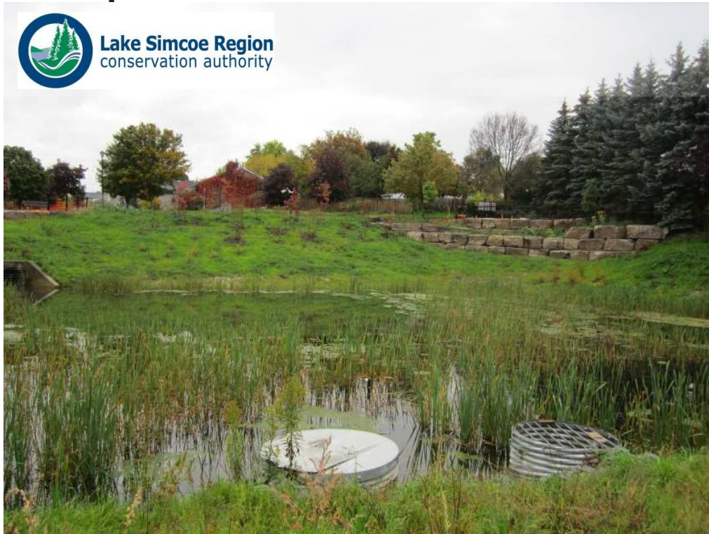
Après la construction de gestion des eaux pluviales étang Rénovation à Colony Trail, East Gwillimbury
